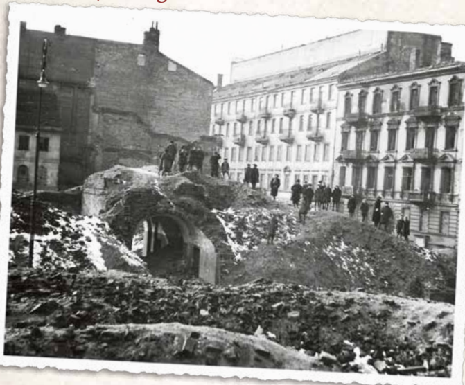
Zniszczone budynki między ulicą Śliską a Sienną
